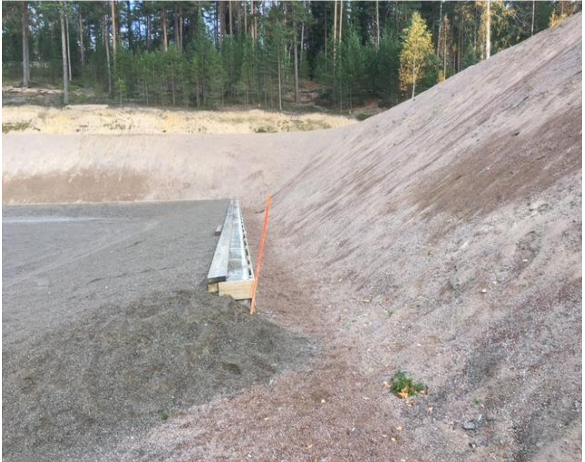
Kuva 3. Metalliset maalit saa asettaa ainoastaan taustavallin ja harkoista rakennetun muurin väliselle alueelle.
